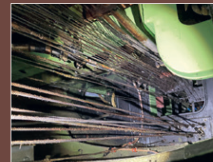
Under golvet bakom cockpit löper alla linor.
