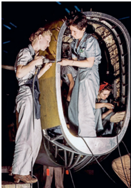
Tre kvinnor arbetar med nitning av en B-24 Liberator-bombare. "Pinnarna" som sticker ut ur de borrade hålen i plåten är tillfälliga klämmor, "Cleos", som används än i dag för att hålla ihop konstruktionen innan nitarna är på plats.
