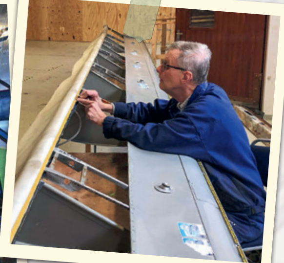
Johan Sundberg i färd med renovering av de långa hatthyllorna. Även de långa värmeakalerna (dukterna) behövde renoveras.
